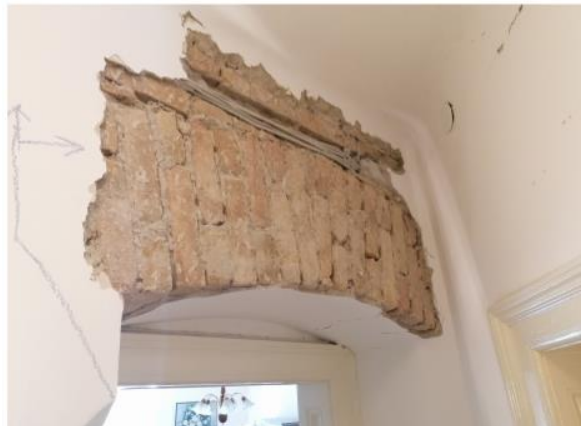
Slika 5.43 Sondažna bušotina 15 – Zidani lučni nadvoj - opeka „starog formata“
