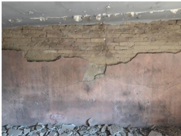
Slika 5.8 Istočni zabat u potkrovlju izbočen van ravnine
