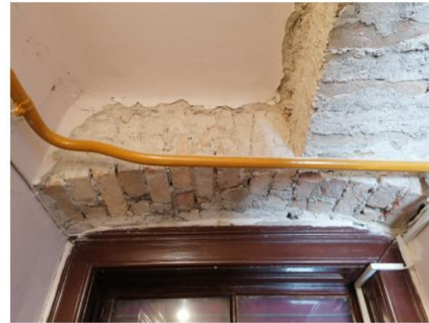
Slika 5.46 Sondažna bušotina 17 – Zidani lučni nadvoj - opeka „starog formata“
