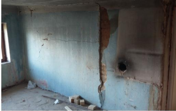
Slika 5.7 Pregradni zid u potkrovlju odvojen od dimnjaka
